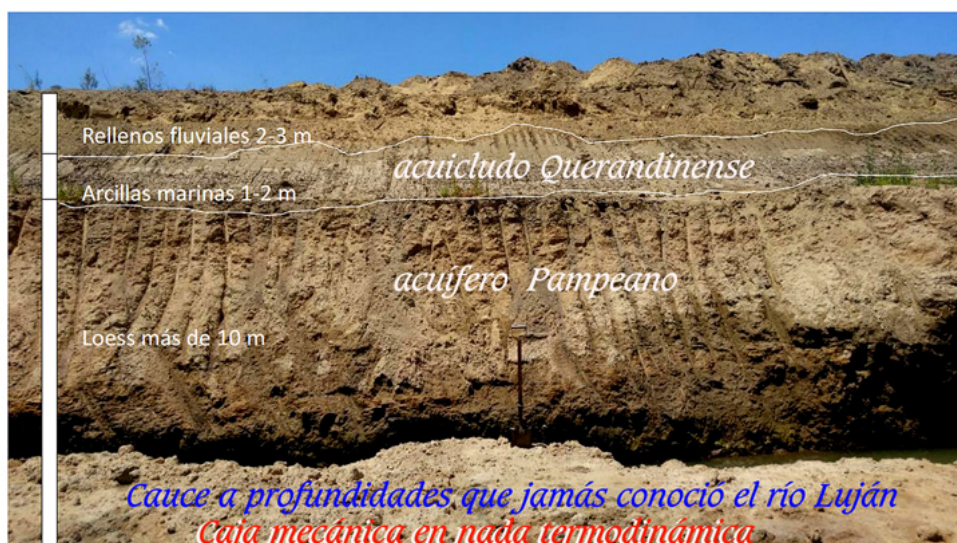
Figura 66: Perfil estratigráfico del área afectada por la obra de ampliación del canal Santa María. Imagen propia.
